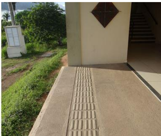
Figura 6: Calçada do Prédio do ILLA unidade III
