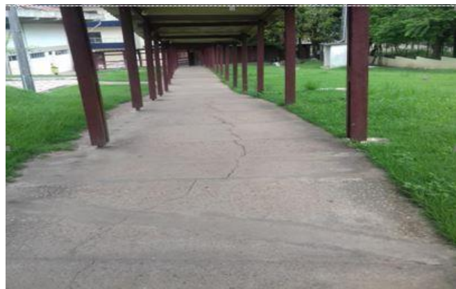
Figura 5: Calçada da unidade II
